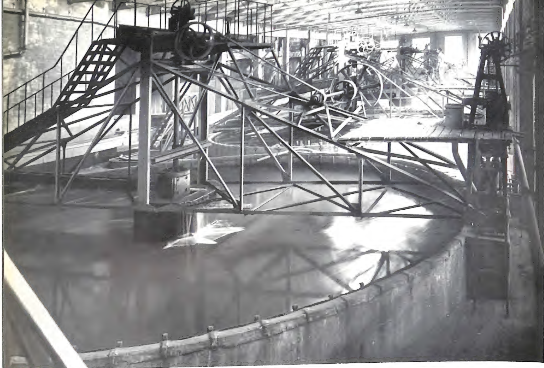
Monteponi - Impianto per lo zinco elettrolitico - Decantatori Dorr.
